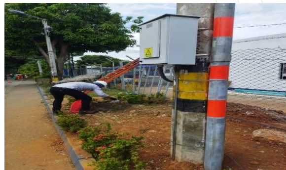
Adecuaciones eléctricas Cauca
